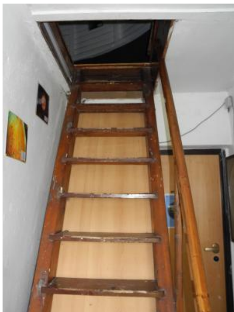
Obr. 12 — Schody pod kopuli.
