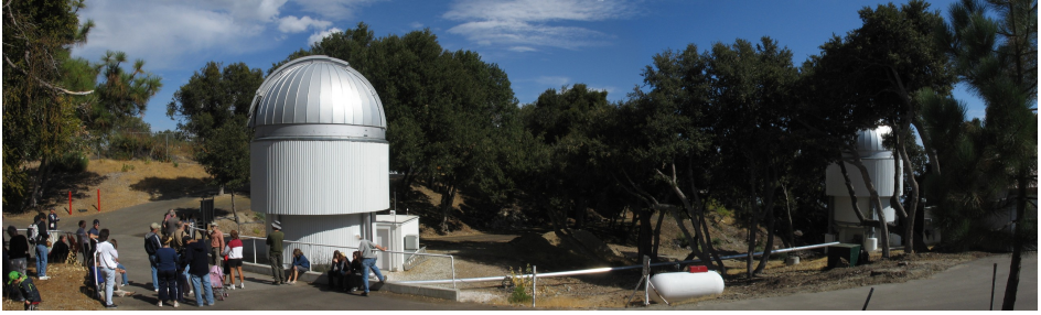
Obr. 1 — Dva ze šesti 1metrových dalekohledů interferometru CHARA na observatoři Mount Wilson. V dolní části snímku je vidět evakuovanou trubici, kterou je světlo vedeno ke zpožďovací dráze (vlevo, nezobrazena).
