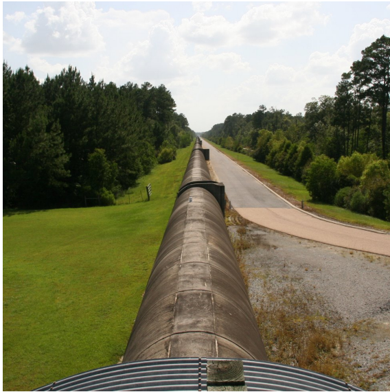
Obr. 2 — Jedno ze dvou 4 km ramen interferometru LIGO Livingston. Při této délce je značné zakřivení Zeměkoule, které činí asi 1 m a muselo se samozřejmě zohlednit při stavbě. Uvnitř betonového tunelu se nachází evakuovaný válec o průměru 1,2 m, který je součástí systému s ultra-vysokým vakuem ( p \simeq 4 \cdot 10^{-7} Pa), aby se omezily fluktuace indexu lomu podél optické trasy a rozptylování záření plynem.
