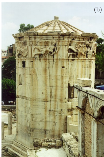
Obr. 12 — Věž větrů v římské agoře pod Akropolí v Athénách, vystavěná Andronikem z Kyrrhesty v letech 50–41 př. n. l. V jejím interiéru fungovaly vodní hodiny (klepsydry), na osmi vnějších zdech orientovaných do základních světových stran je umístěno osmero slunečních hodin s kolnými ukazateli. Na všech číselnících jsou značeny temporální hodiny. (a) Pohled od SV, (b) od JZ, (c) od S, (d) od JV. Foto Martin Šolc (2003).
