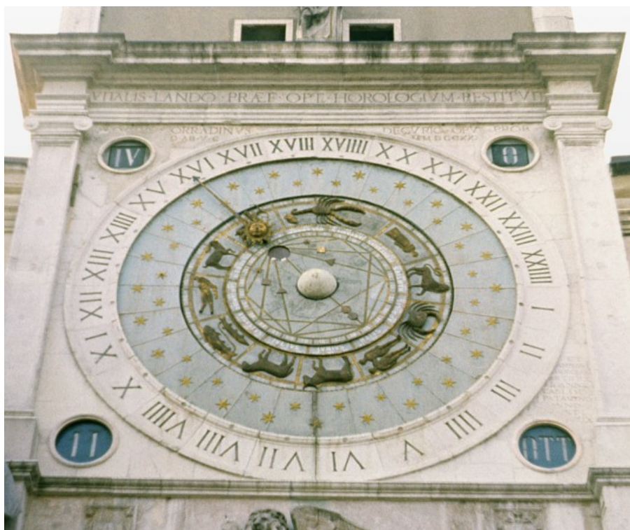
Obr. 17 — Astronomický orloj v italské Padově, zkonstruovaný Giovannim de Dondim v letech 1344 až 1364. Je považován za vůbec nejstarší zařízení svého druhu. Orloj je vybaven 24 hodinovou stupnicí s římskými číslicemi a dělením po půl hodině. Na ní ukazuje ručička se symbolem Slunce středoevropský čas. V kruhových okénkách nahoře se tento časový údaj opakuje v číselné podobě: jako poloorlojní římská číslice pro hodiny a arabská číslice pro minuty (s časovým krokem pět minut). Dolní dvě okénka jsou vyhrazena pro datum (den v měsíci a třípísmennou zkratku měsíce). Uvnitř hodinové stupnice se nachází zvěrokruh s plastickými symboly znamení (chybí však znamení Vah) a příslušnými kalendářními daty. Slunce se pohybuje nad zvěrokruhem a lze tak číst, v jakém znamení se právě nachází. Koule ve středu orloje znázorňuje Zemi. Okolo ní se pohybuje měsíc, který je realizován jako excentrický kruhový otvor v disku obepínajícím zemi. V otvoru je pak světlým nebo tmavým podkladem znázorněna fáze Měsíce. (Momentálně je Měsíc proti Slunci, tedy v novu, a kotouček je celý černý.) Úsečka, trojúhelník, čtverec a šestiúhelník vztahující se k poloze země a měsíce mají astrologický význam. Foto Miroslav Brož (1999).
