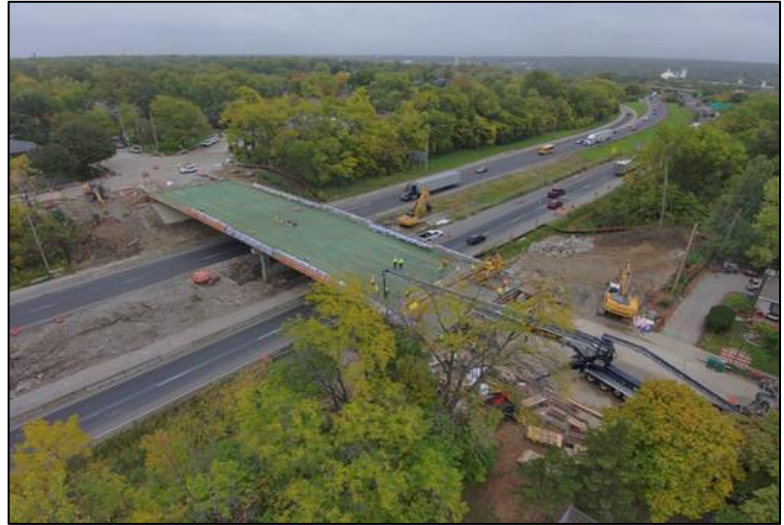
Bridge deck pour on Wheeler Avenue over I-80
