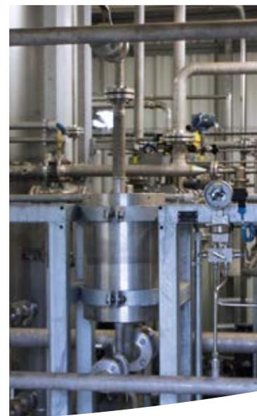
两种过程的成功组合：采用分离膜段和变压吸附 (PSA) 的混合装置
