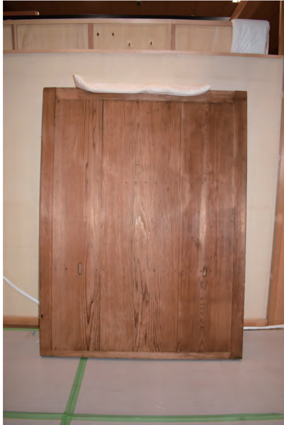
口絵 1 遠侍帳台の間 帳台構襖（東より1）障壁画を捲った状態
