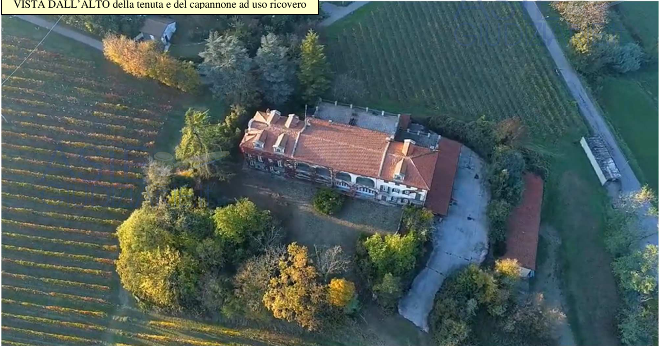
VISTA DALL'ALTO della tenuta e del capannone ad uso ricovero
