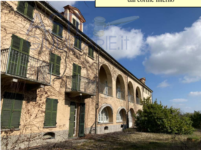
VISTA del fabbricato facciata sud-est dal cortile interno
