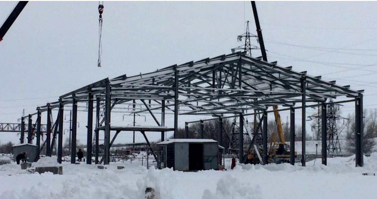
Строительство Склада НОУ МАГАТЭ на Ульбинском металлургическом заводе в Усть-Каменогорске, 2017 год.
