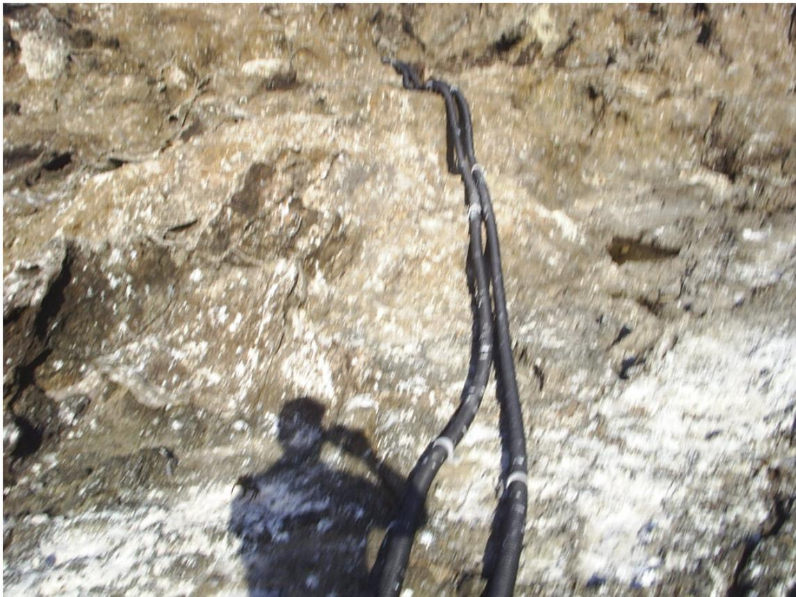
**Figura 13.** Fixação do conduíte direto no solo.
