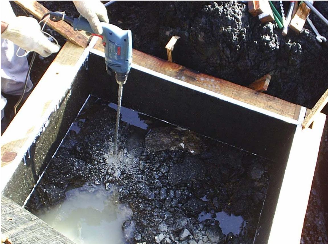
**Figura 4.** Perfuração dos furos de fixação da base de concreto da Torre do Flutua no ASPSP. A base da torre com 750 kg de concreto foi fixada na rocha com cinco barras roscadas com 60 cm profundidade. Caixa de madeira usada como forma para fundir a base de concreto.
