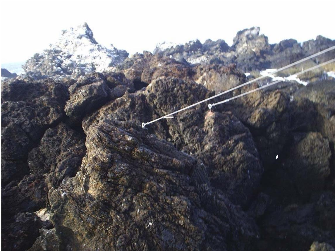
**Figura 7.** Fixação do hasteio no solo. Lado Norte da torre. Foi utilizado barra roscada e olhal de aço inoxidável. Perfuração na rocha atingiu cerca de 30 centímetros de profundidade. Barra roscada foi fixada com cola plástica.
