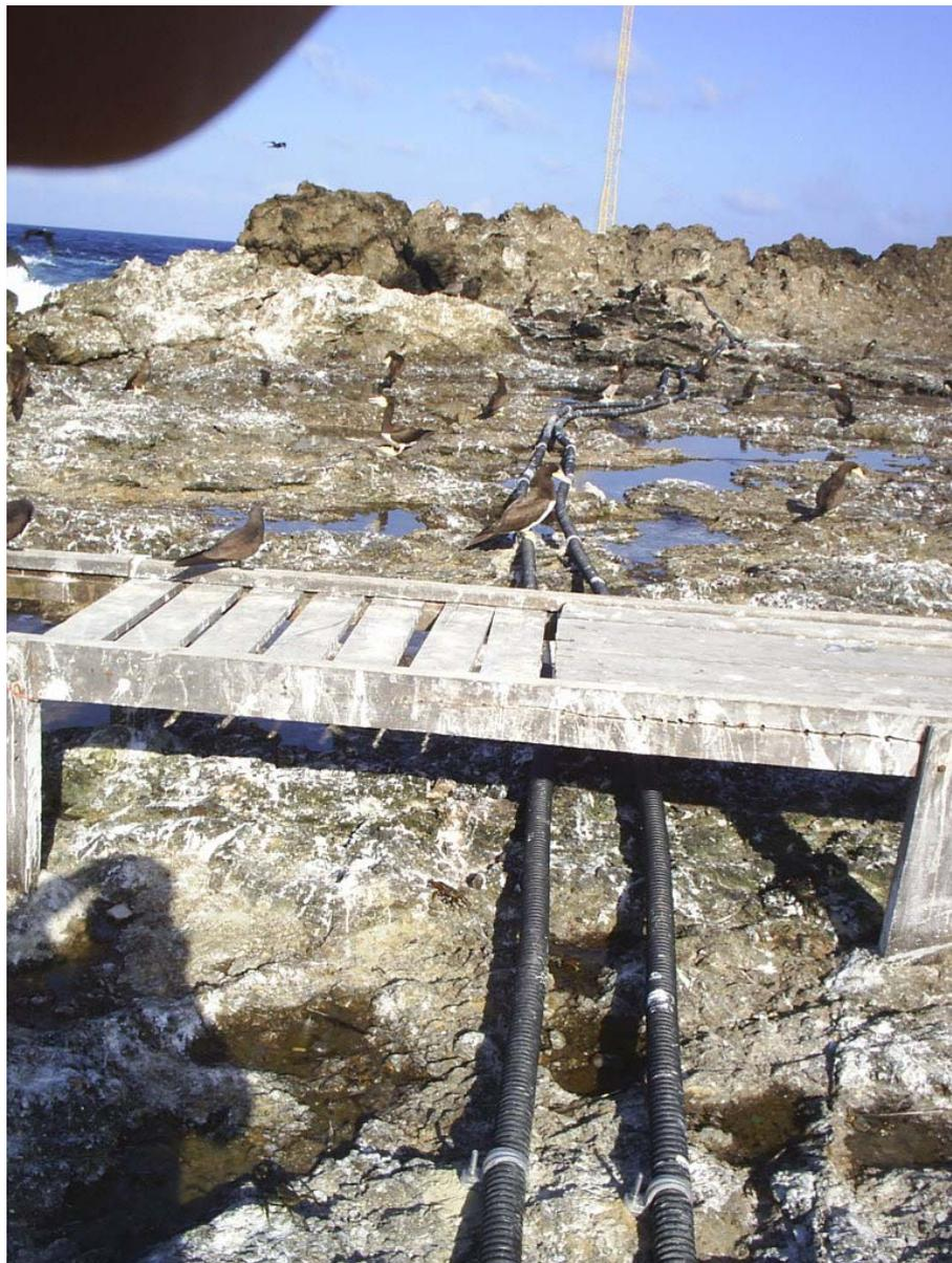
**Figura 14.** Fixação do conduíte sob a atual passarela.
