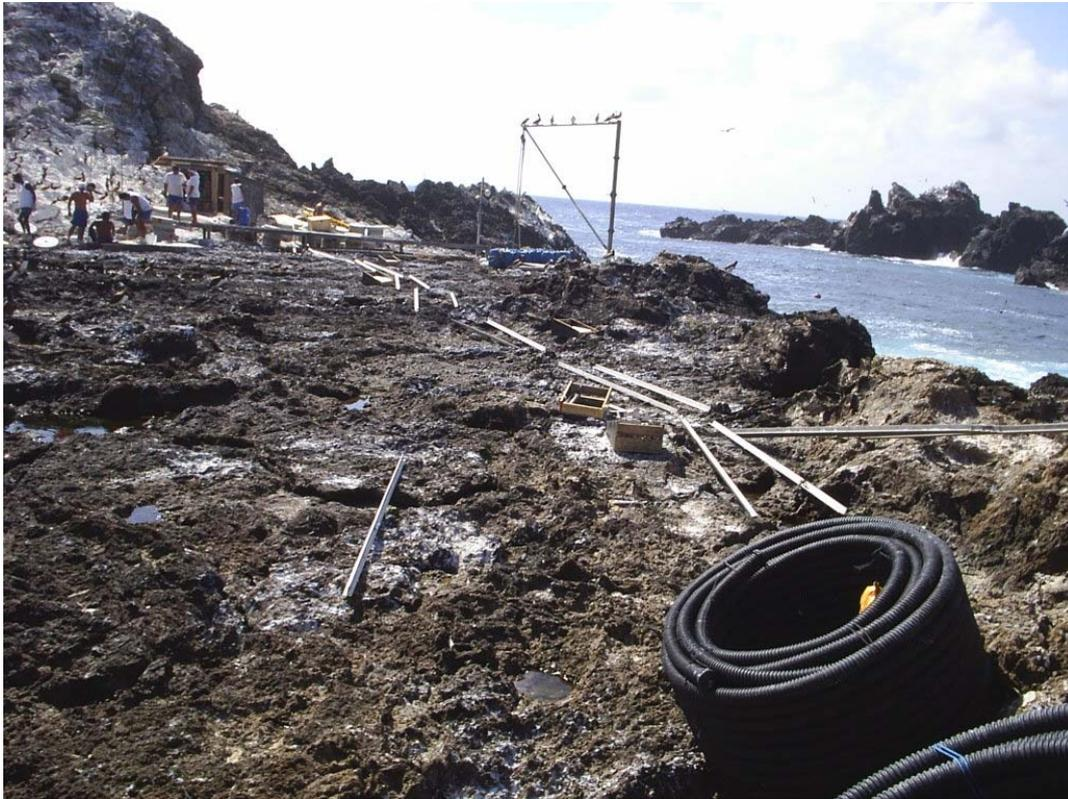
**Figura 9.** Preparação das canaletas de fixação do condute de ligação entre os equipamentos da torre e a cabine de aquisição de dados.
