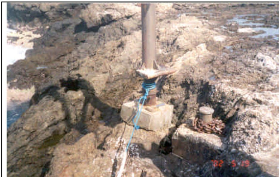
**Figura 7:** Base de sustentação do Turco. Modelo de base para sustentação da Torre Micrometeorológica.
