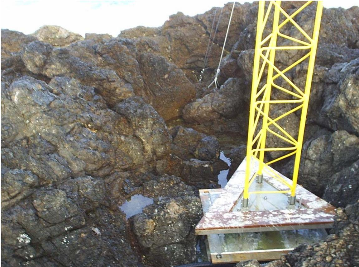
**Figura 5.** Base de fixação da torre.
