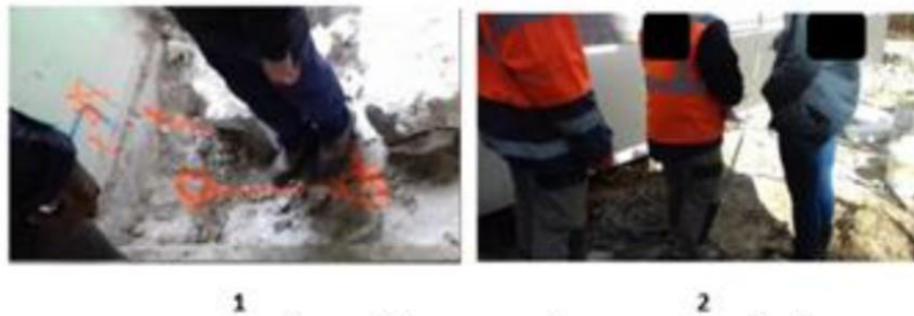
Figure 3 : la mobilisation du corps sur le chantier
