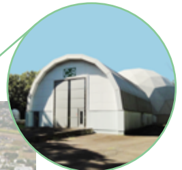
磁気試験設備 測定中は、地球の磁場を打ち消して正確に測定します(まさにゼロ磁場)
