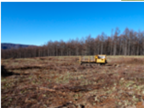
立木の伐採完了 2015年12月22日撮影
