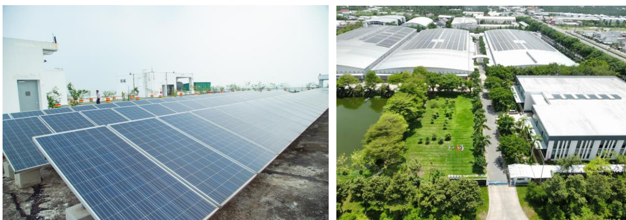
Solaranlagen auf den Fabrikdächern unserer Lieferanten in Bangladesch und Vietnam
