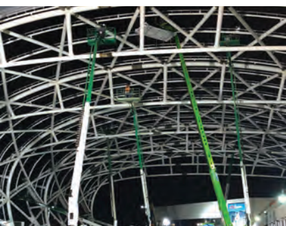
36 Atlanta Int'l Replaces Exterior Façade & Adds Lighted Canopies
