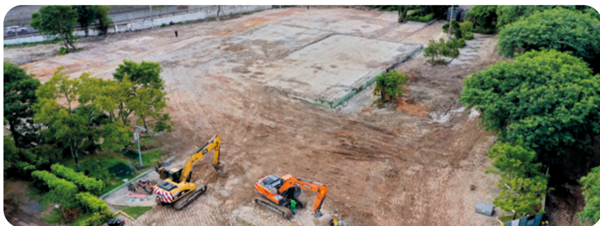
Divulgação | FBI Demolidora
