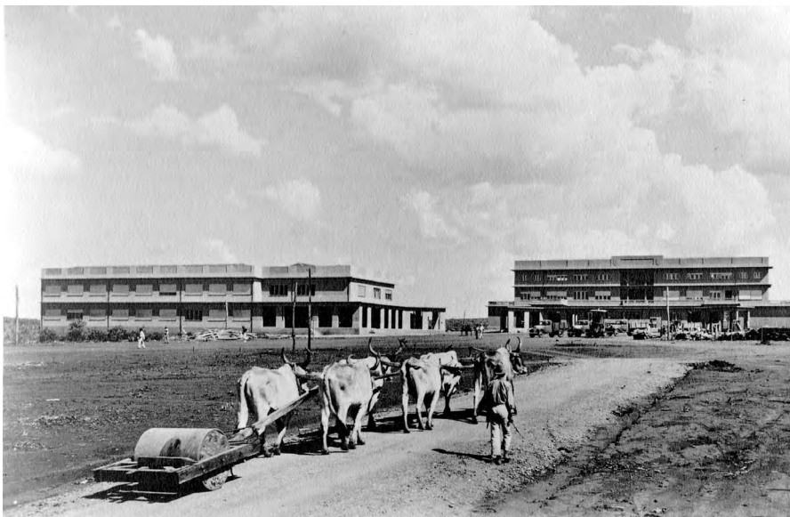
Figura 3 - Obras de construção da cidade de Goiânia, entre 1935 e 1937
