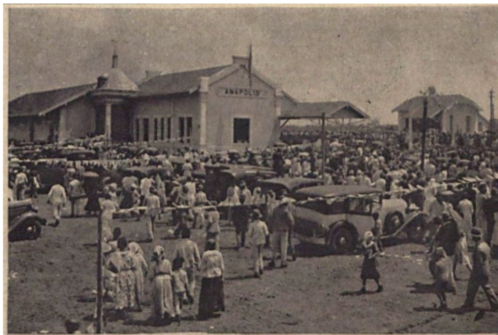
Figura 5 - Inauguração da Estação Estrada de Ferro na cidade de Anápolis, em 7 de setembro de 1935
