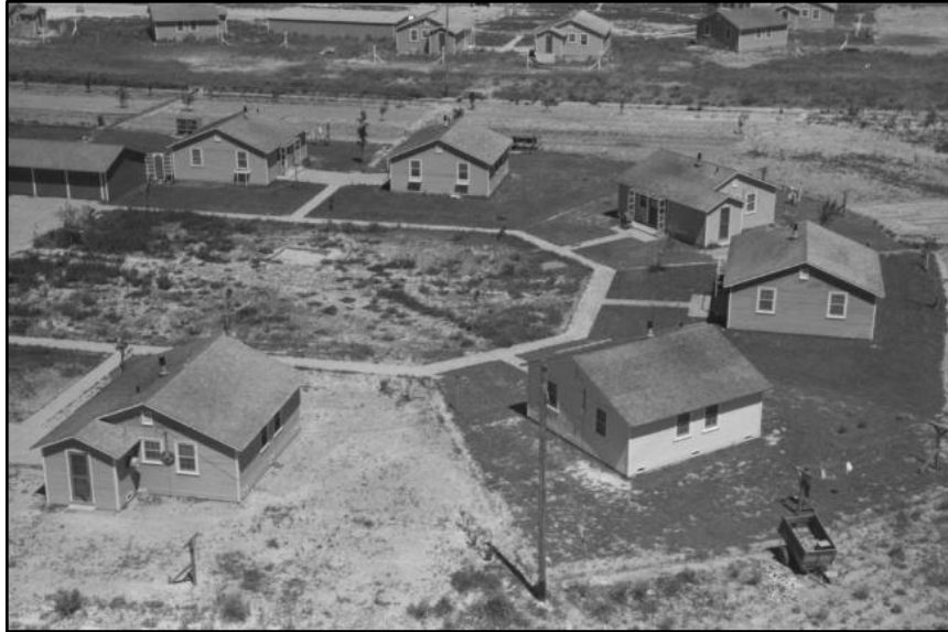
Figura 3-17. Las pequeñas casas del campamento de Caldwell, fotografiadas en 1941, eran similares en estilo a las del campamento de Twin Falls. Library of Congress, Prints & Photographs Division, FSA-OWI Collection, LC-USF33-013032-M4.
