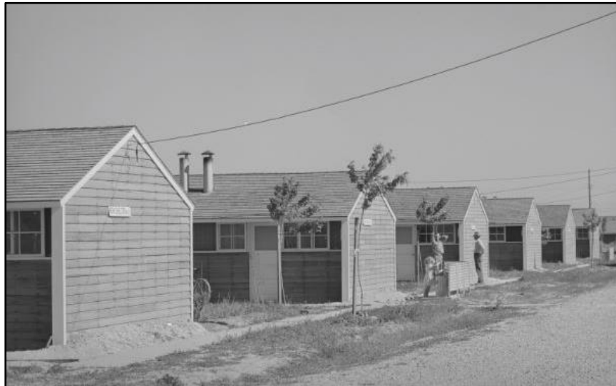
Figura 3-19. Los edificios de estilo cuartel en el campamento de Caldwell, 1941 Library of Congress, Prints & Photographs Division, FSA-OWI Collection, LC-USF34-D039194-D.
