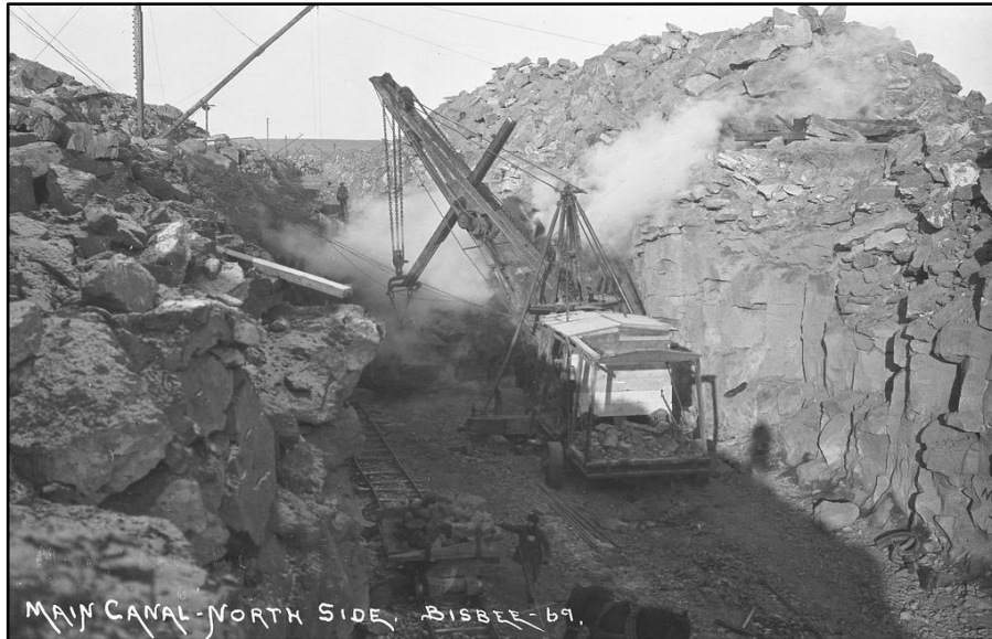
Figura 1-1. Una pala de vapor excava el canal del lado norte de la presa Milner, CA. 1906. Twin Falls Public Library, Clarence E. Bisbee Collection, PC-2084.
