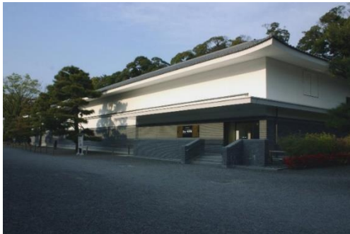
「二条城障壁画 展示収蔵館」外観
