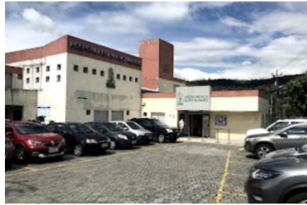
Fotografía 2: Instalaciones externas del Hospital del día Eloy Alfaro
