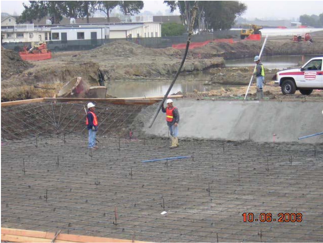
POURING CONCRETE PAD
