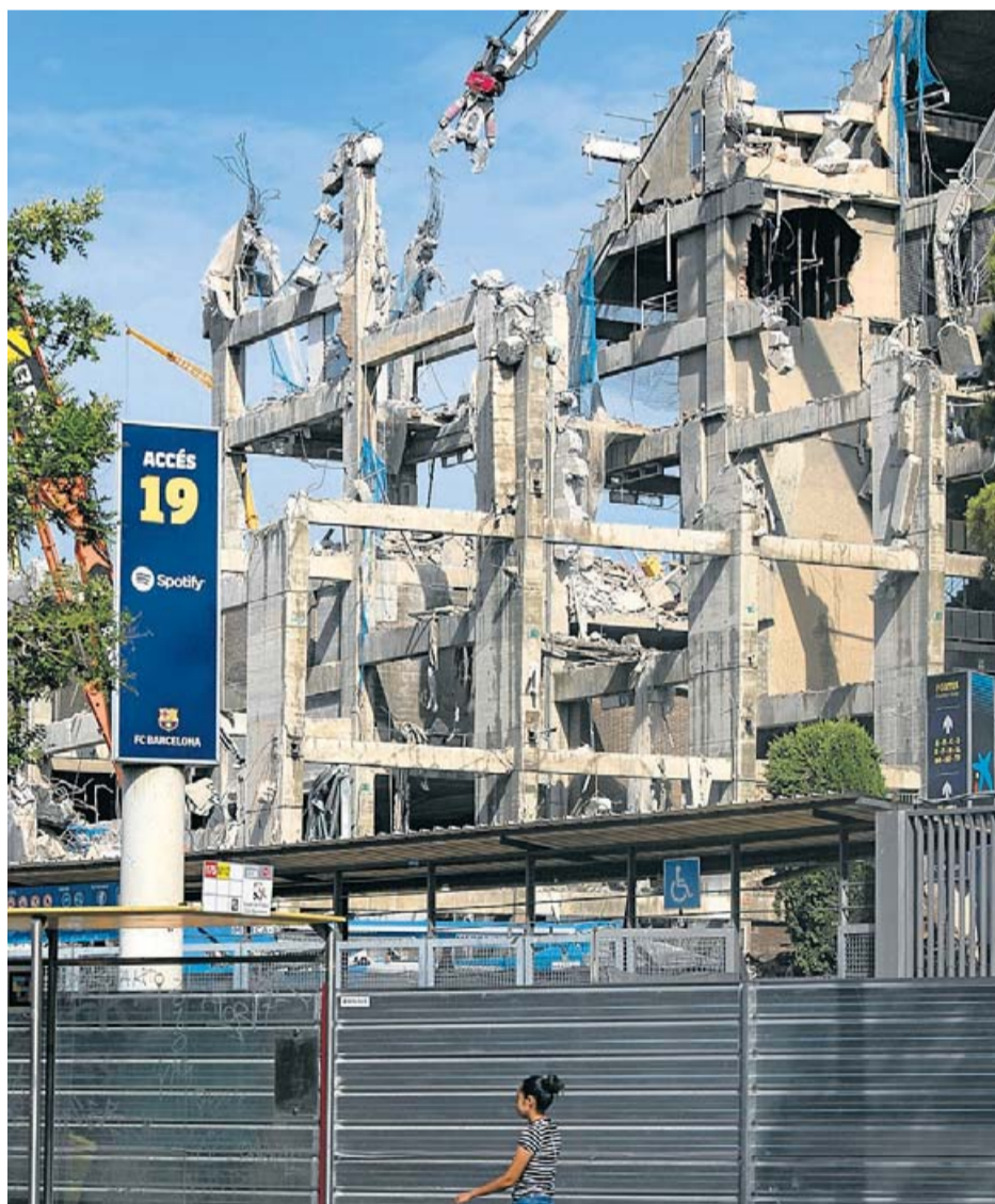
L'accés 19 del Camp Nou en plens treballs de demolició. FRANCESC MELCION
