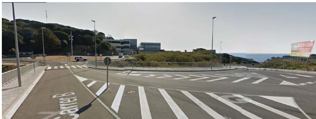
Zona d'inici en el costat nord del vial de Valldegata
