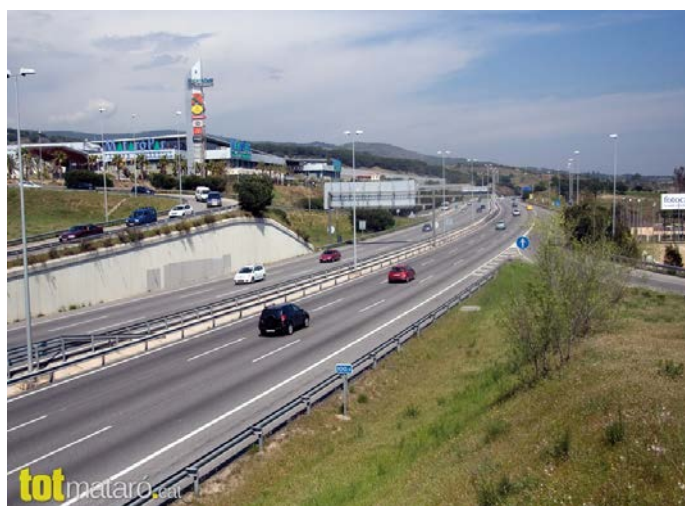
Autopista C-32 a Mataró
