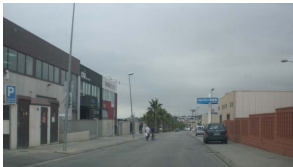
Exemple de tram de xarxa urbana que canalitza elevats volums de trànsit interurbà
