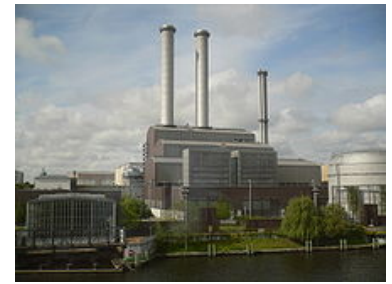
Power plant Heizkraftwerk Mitte
