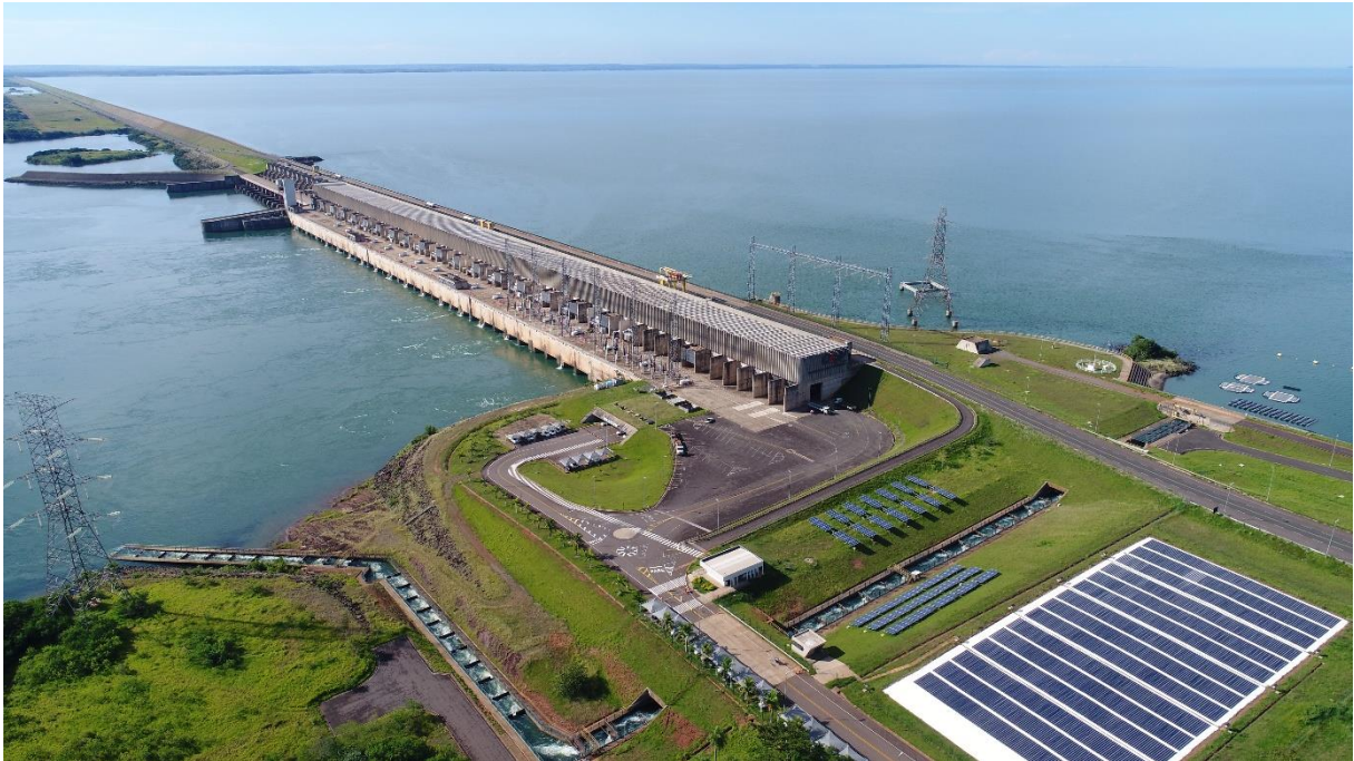
Figura 1 – Vista geral da barragem da UHE Porto Primavera
