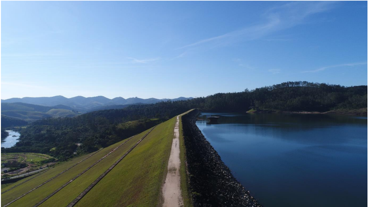
Figura 1 – Vista geral da barragem da UHE Paraibuna
