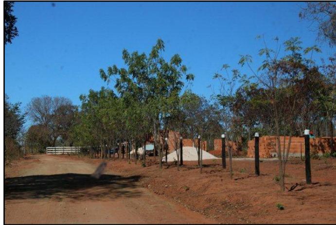
Construções em alvenaria em instalação
