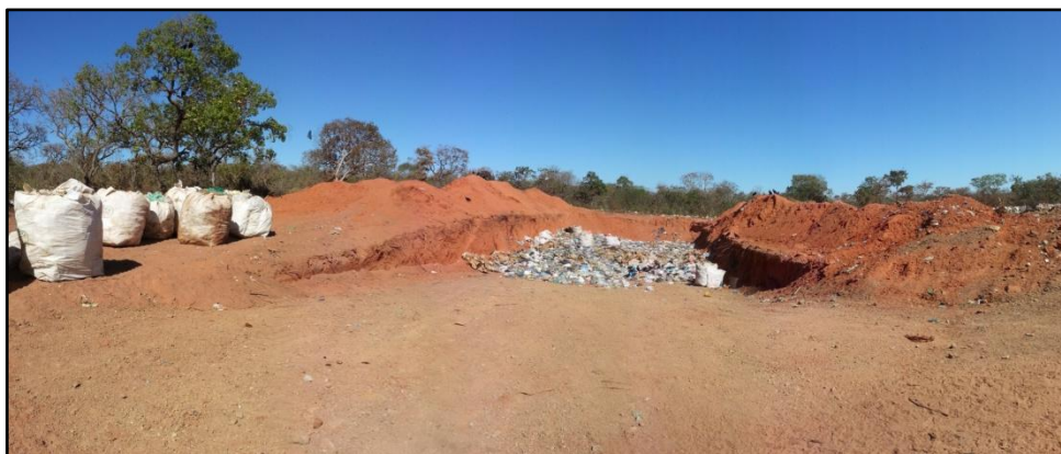
Vala com acúmulo indiscriminado de resíduos para posterior aterramento
