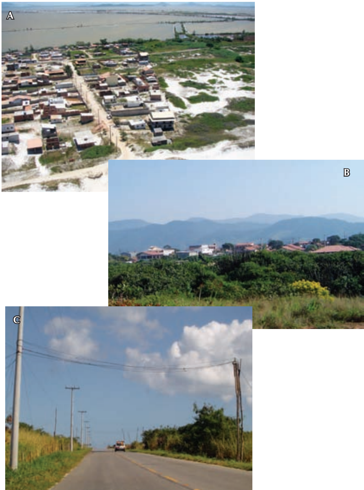
Fig. 7 – Ameaças sofridas pelo Formigueiro-do-litoral nas restingas do litoral fluminense, RJ, Brasil. A) Avanço de áreas construídas às margens da Lagoa de Araruama, Arraial do Cabo, B) Expansão de loteamentos na vegetação de restingas em Jaconé, Saquarema, C) Ligações clandestinas de fios elétricos na APA de Massambaba, Cabo Frio.
