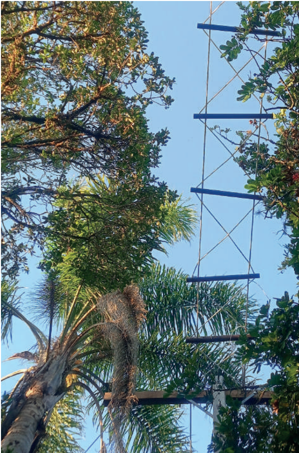
Figura 4 - Ponte de dossel que permite a travessia segura da fauna arborícola.
