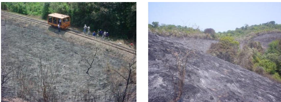
FIGURA 10 – Fotos do incêndio que atingiu a REBIO de Poço das Antas em setembro de 2004, mostrando do local onde o incêndio teve origem durante as atividades de manutenção da linha férrea (esquerda) e a vista parcial da área queimada conhecida como Barro Branco (direita).
