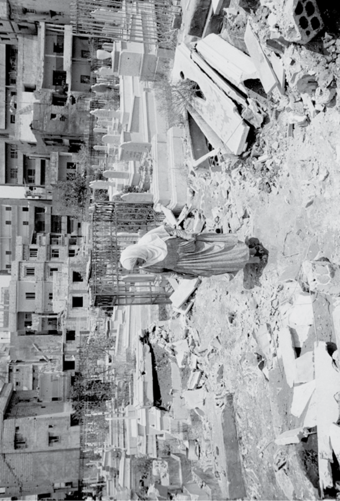
Porušeno pokopališče. Bejrut, Libanon, 1982. Foto: MORK/Luc Chessex.
