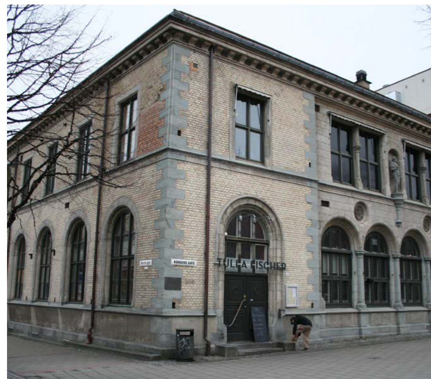
Reppesandstein i hjørner og gesimser i den gamle børsbygningen (nå Café Grafen), Trondheim
