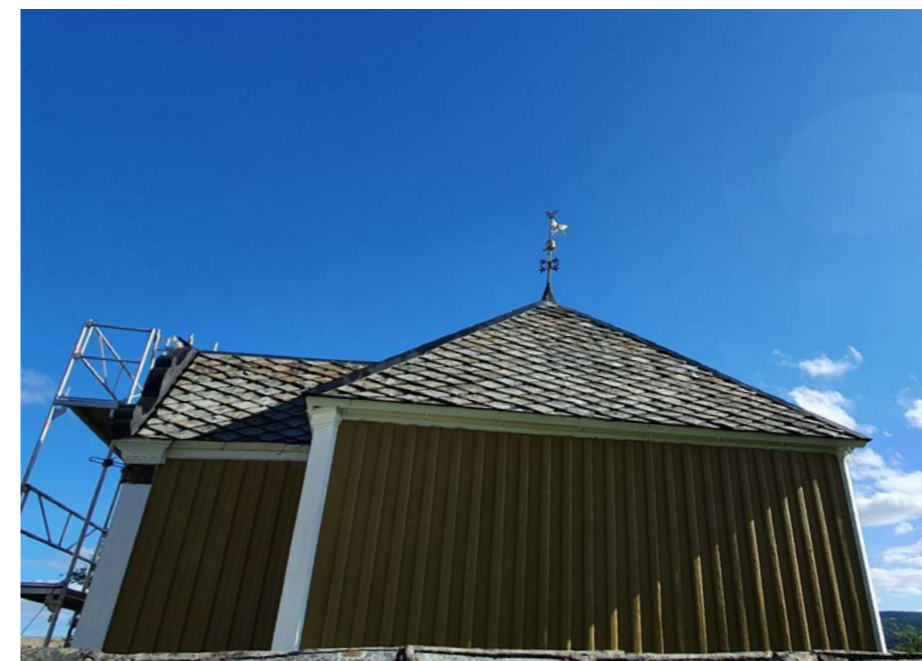
Hiortkapellet på Røros det taket er tekktet med femkantet skifer. Steinen varierer mellom fyllitt og meta gråvake og inneholder en del kalk. Hiortkapellet ble oppført i 1782, men taket kan være byttet ut siden.
