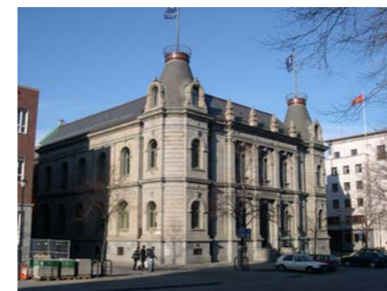
Sparebanken fra 1884. Nordens første helsteinsbygning i moderne tid. Bygget av Hovinsandstein med elementer av larvikitt, Allmenningsmarmor og kleberstein.
