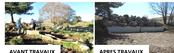
Réhabilitation d'un point d'eau via le Pacte Cantal
