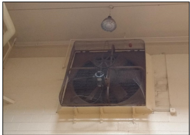
Wall Propeller Fan (typ. of 2)
